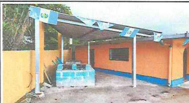
Foto 3:Modulo 3 Mejoramiento de cocina. Mejoramiento de galera por paredes de Block.
