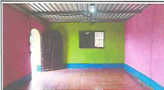
Foto 4: modulo 4 Mejoramiento con pintura y balcones instalacion de piso ceramico
