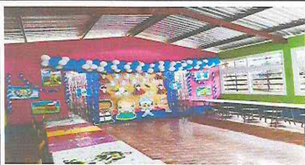
Foto1: Modulo1 sustitucion de lamina, por lamina troqueleada alucin calibre 26 y mantenimiento a estructura.
