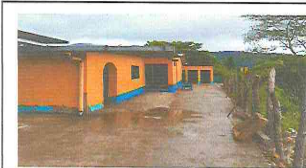
Foto 5: Modulo 6 MEJORAMIENTO DE PATIOS, PAVIMENTO EN PATIOS
