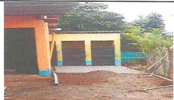
Foto 2: Modulo 2 Mejoramiento de baños, sustitucion de inodoros, mantenimiento puertas, cambio de lamina troqueleada y estructura.
