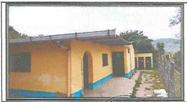
Foto 6: Modulo 5. Pintura General
