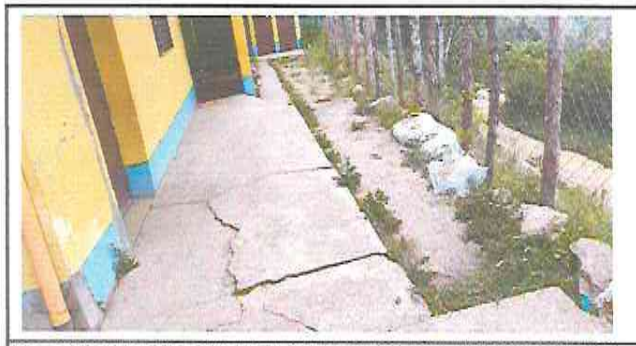
Foto 5: Modulo 6 MEJORAMIENTO DE PATIOS, PAVIMENTO EN PATIOS
