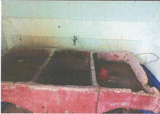
Foto 3: sustitucion de pila por pila de 2 lavadores y suministros.
