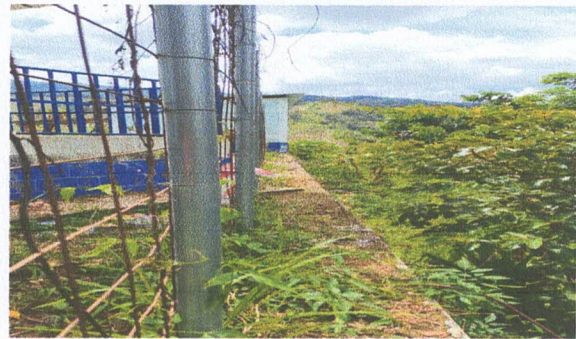
Foto 4: mantenimiento con pintura a muro perimetral de electro maya.
