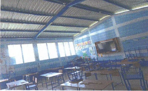
Foto 1: pintar muros exteriores e interiores.
