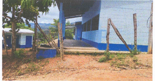
Foto 2: instalar porton con maya y tubo redondo galvanizado de 2.00x2.00 con columnas de concreto.
