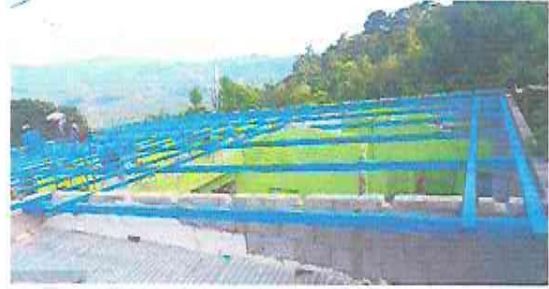
Foto 2: ESTRUCTURA DE METAL
