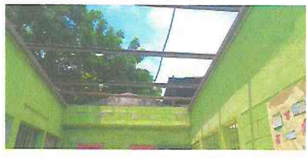
Foto 2: ESTRUCTURA DE METAL
