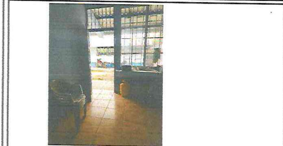
Foto 7: sustitución de piso de concreto por piso ceramico en la Dirección
