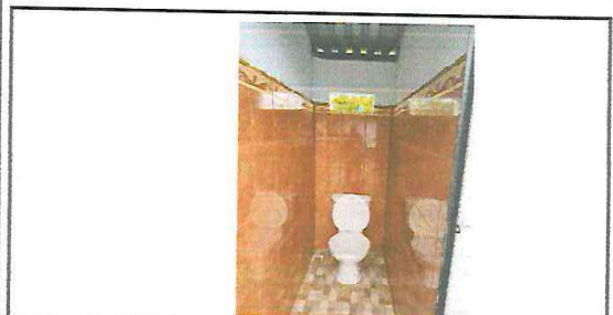
Foto 11: Sustitución de piso de concreto por piso ceramico en baños
