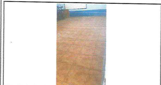
Foto 9: Sustitución de piso de concreto por piso ceramico en el aula 2
