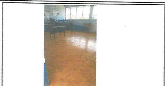
Foto 8: Sustitución de piso de concreto por piso ceramico alula 1
