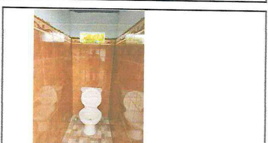
Foto 10: Sustitución de piso de concreto por piso ceramico en baños
