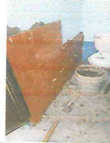
Foto 10: Sustitución de piso de concreto por piso ceramico en baños
