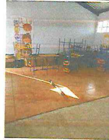
Foto 8: Sustitución de piso de concreto por piso ceramico alula 1
