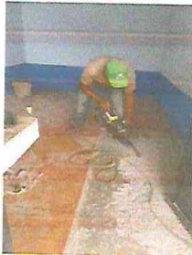
Foto 7: sustitución de piso de concreto por piso ceramico en la Dirección
