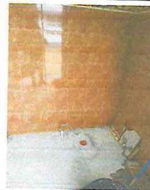
Foto 12: Sustitución de piso de concreto por piso ceramico en baños
