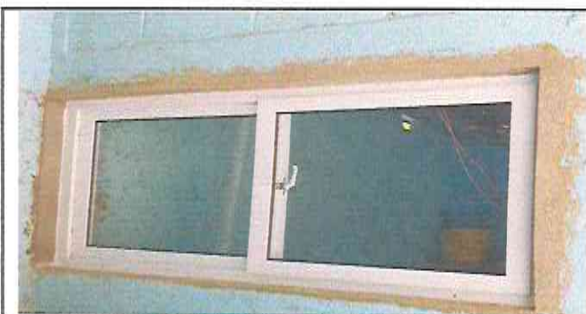
Foto 5: Trabajo terminado de ventanas de celosía de cemento por ventana de PVC 0.85 x 1.00 mts
