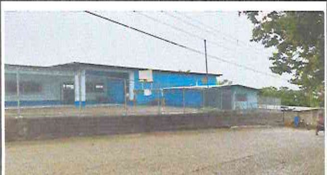
Foto1: Trabajo terminado de muro perimetral con malla y tubo HG
