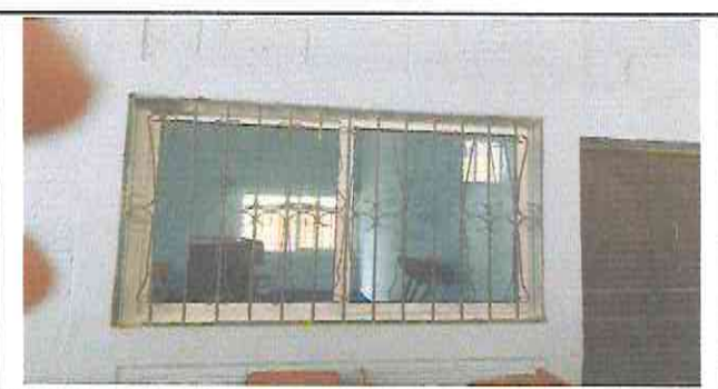
Foto 6: Trabajo terminado de ventanas de metal por ventanas de PVC 0.85 X 1.28 mts
