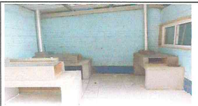
Foto 3: Trabajo terminado de estufa rural con plancha y chimenea
