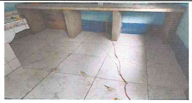
Foto 2: Trabajo terminado gabinete fundido con muros de block
