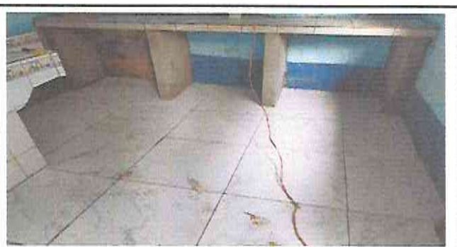
Foto 4: Trabajo terminado en colocación de piso cerámico
