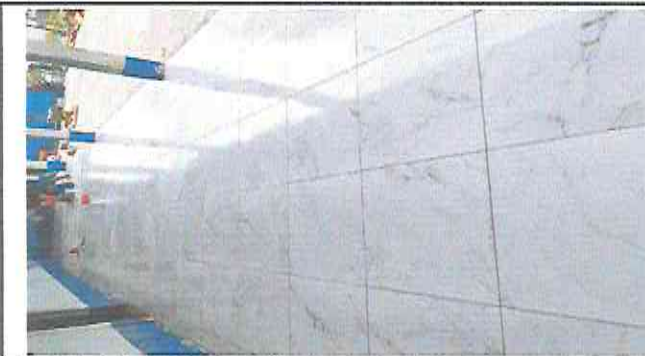
Foto 9: Trabajo terminado sustitución de piso de torta de cemento por piso cerámico
