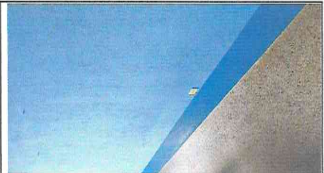
Foto 8: Trabajo terminado en pintura de muros en dos aulas parte interior
