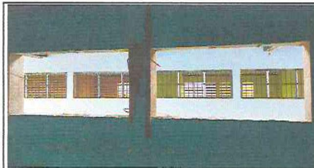
Foto 5: Trabajos de abrir vano y ventana de PVC 0.80 X 1.00 mts
