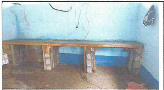
Foto 2: Trabajos de gabinete fundido con muros de block
