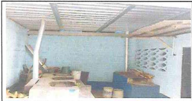
Foto 6: Sustitución de lamina troquelada por lámina troquelada de 14 pies
