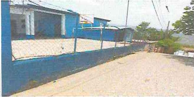
Foto 1: Sustitución de muro perimetral malla, por block
