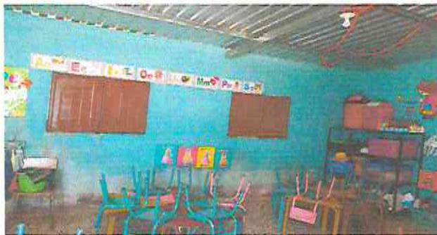
Foto 7: Cambio de ventanas de metal por ventanmas de PVC, de 0.85 x 1.00 mts
