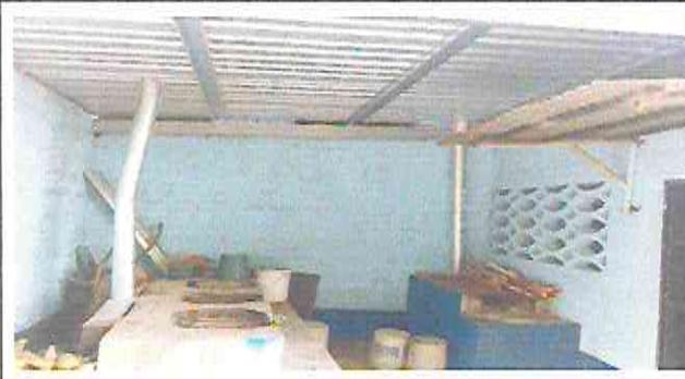
Foto 3: Sustitución de hornilla, hechura de 3 polletones con plancha y chimenea
