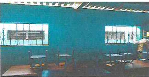
Foto 9: Abrir vana y colocar ventana de PVC de 0.80 x 1.30 mts
