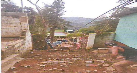
1.1. MEJORAMIENTO DE INGRESO A LA ESCUELA (RAMPA)
