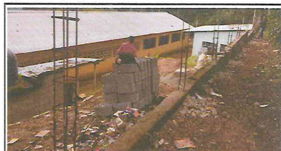
2.1. MEJORAMIENTO DE MURO PERIMETRAL CON BLOCK DE 15X40 PARTE TRACERA.
