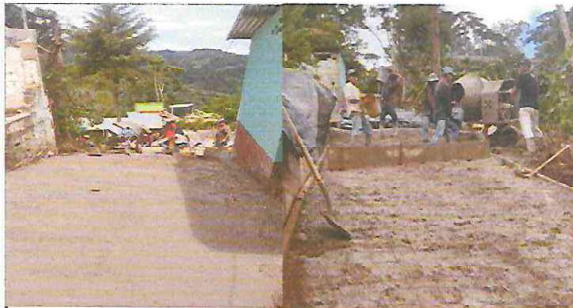
1.1. MEJORAMIENTO DE INGRESO A LA ESCUELA (RAMPA)
