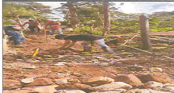
1.1. MEJORAMIENTO DE INGRESO A LA ESCUELA (RAMPA)
