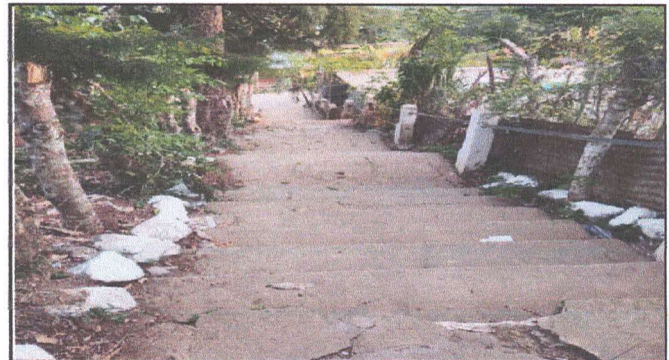
Foto 2: SUSTITUCION DE GRADAS, POR PAVIMENTO.
