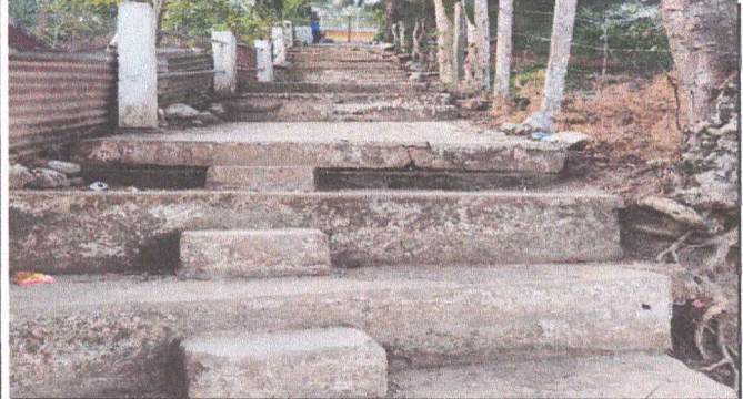
Foto 1: SUSTITUCION DE GRADAS, POR PAVIMENTO.
