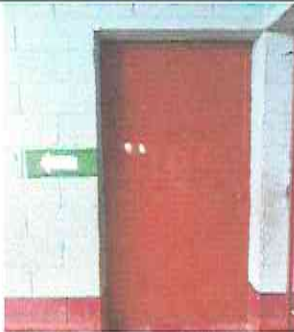
Foto 5: Mantenimiento de puertas.
