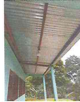
Foto 8: Colocación de lamparas led.
