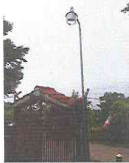
Foto 9: Instalación de lampara fotoselda.
