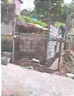
Foto 1: Reparación del muro de contención.
