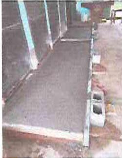
Foto 3: Aplicación de torta de concreto para luego colocar piso antideslizante.
