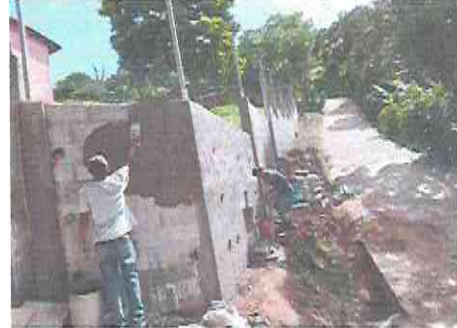
Foto 2: Aplicación de repello del muro de contención.
