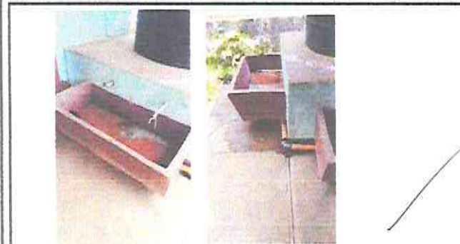
Foto 5v: Sustitución de grifos y sustitución de azulejos
