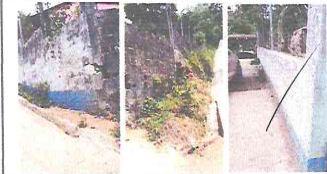
Foto 7: Reparación de muro de contención y aplicación de repello
