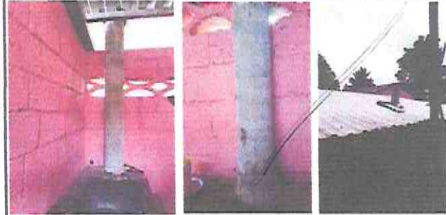
FOTO 8: Reparación de chimenea de concreto
