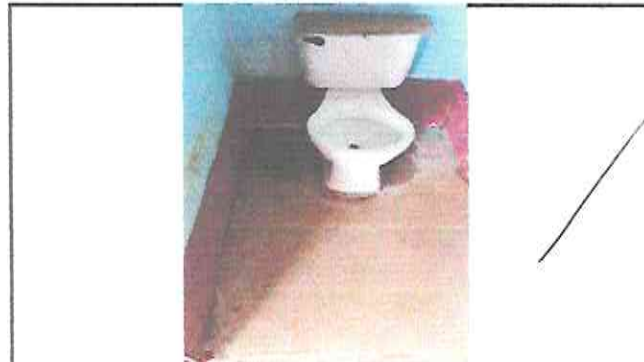
Foto 4: Sustitución de inodoros
