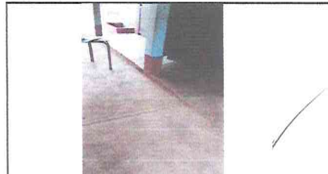
Foto 6: Sustitución de torta de concreto por piso antideslizante
