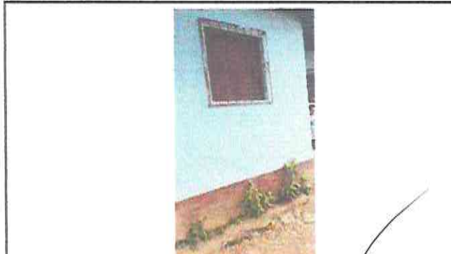
Foto 2: Sustitución de ventanas de madera por pvc
