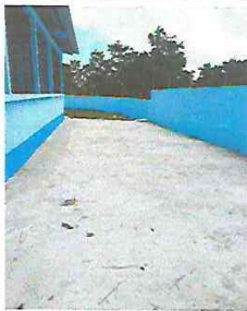
Foto 5: Pintura de muros interiores
