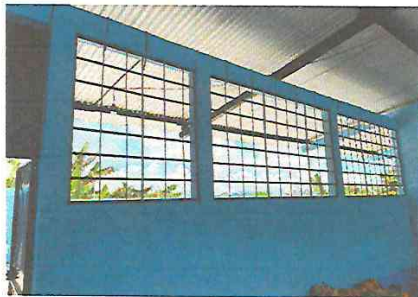
Foto 3: Remozamiento de balcones
