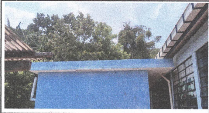
Foto 9: INSTALACIÓN DE DEPÓSITO DE AGUA 1100 LT
