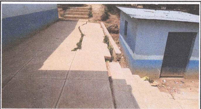
Foto 10: REPARACIÓN DE PLANCHA DE CONCRETO DE BANQUETA
