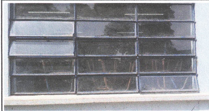
Foto 1: SUSTITUCIÓN DE VENTANAS TIPO BALCÓN POR VENTANAS DE PVC
