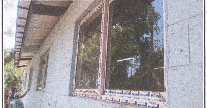
Foto 2: INSTALACIÓN DE BALCONES PARA VENTANA DE PVC
