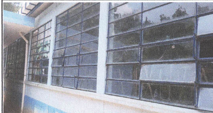
Foto 3: MANTENIMIENTO A ESTRUCTURA DE METAL DE VENTANA
