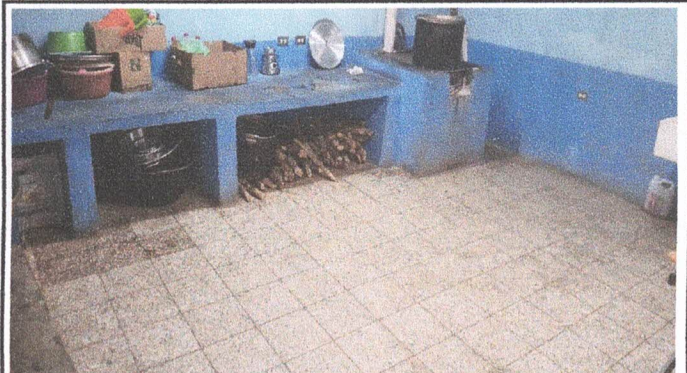
Foto 8: INSTALACIÓN DE AZULEJO EN MUEBLES DE COCINA
