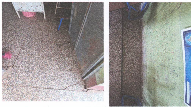
Foto 3: REPARACIÓN DE PISO DE GRANITO
