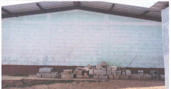
Foto 4: PINTURA EN MUROS EXTERIORES E INTERIORES
