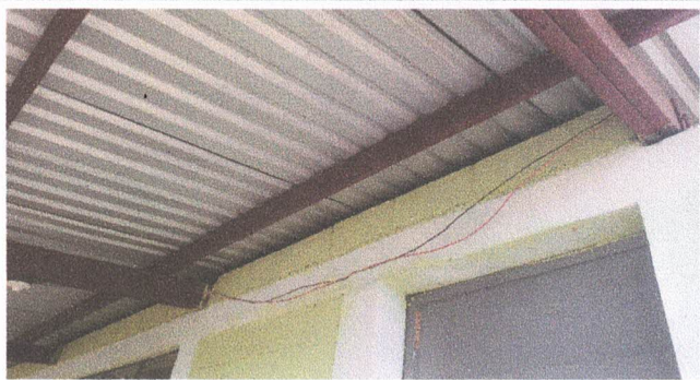
Foto 5: SUSTITUCIÓN DE DUCTO ELECTRICO + ACCESORIOS
