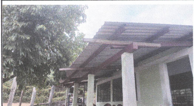
Foto 8: INSTALACIÓN DE CANALES DE PVC Y BAJADA PLUVIAL ✓
