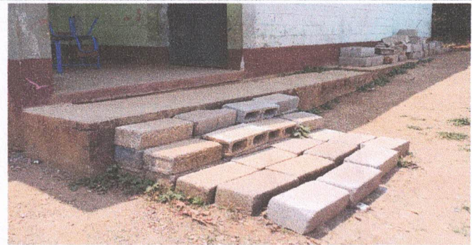
Foto 6: REPARACIÓN DE BANQUETA Y GRADAS DE ACCESO A AULA
