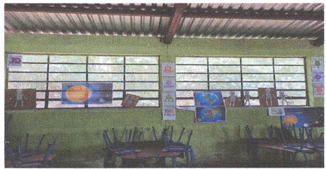
Foto 2: CAMBIO DE VENTANA TIPO BALCÓN POR VENTANA DE PVC CORREDIZA
