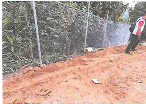
Foto 2: SUMINISTRO E INSTALACION DE TUBO HG Y MALLA GALVANIZADA
