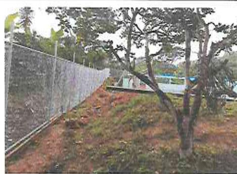
Foto 4: SUMINISTRO E INSTACION DE TUBO HG Y MALLA GALVANIZADA
