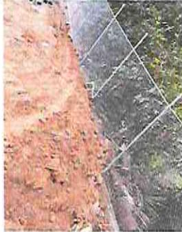
Foto 1: SUMINISTRO E INSTALACION DE TUBO HG Y MALLA GALVANIZADA
