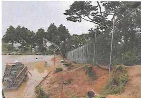
Foto 3: SUMINISTRO E INSTALACION DE TUBO HG Y MALLA GALVANIZADA
