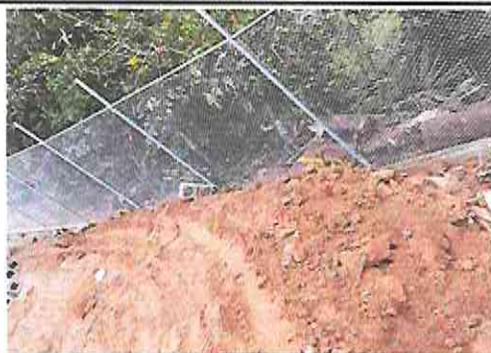
Foto 5: SUMINISTRO E INSTALACION DE TUBO HG Y MALLA GALVANIZADA
