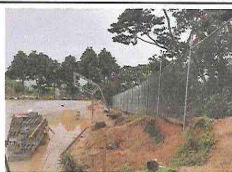
Foto 6: SUMINISTRO E INSTALACION DE TUBO HG Y MALLA GALVANIZADA
