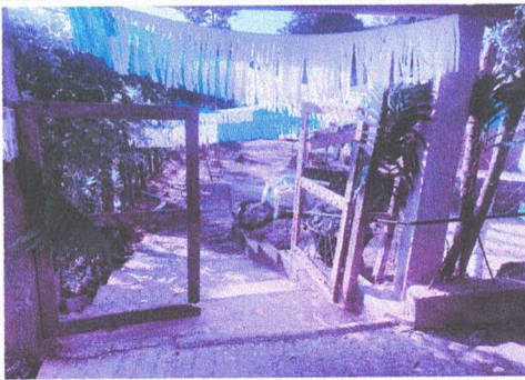
Foto 5: Sustitucion de porton de madera por un porton de metal
