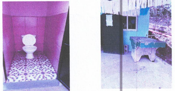
Foto 6: Sustitucion de accesorios de baños y colocacion de azulejos a la pila
