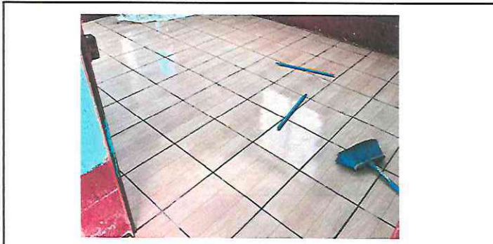
Foto 9: Sustitución de piso de granito por piso ceramico Dirección
