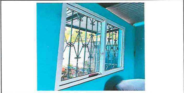
Foto 13: Matenimiento a balcones de metal
