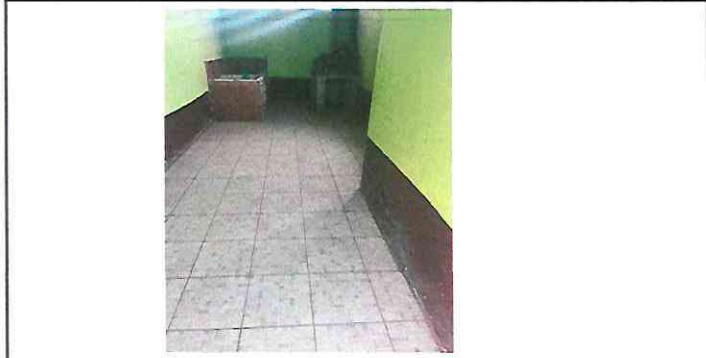
Foto 15: Sustitución de piso de torta de concreto por piso ceramico
