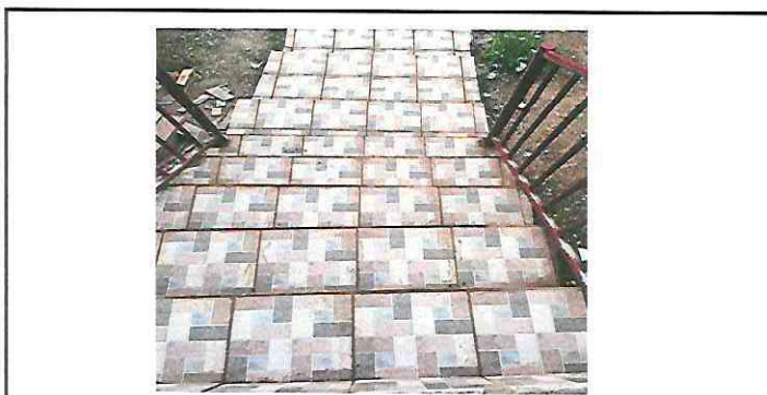
Foto 11: Sustitución de piso de torta de concreto por piso ceramico en gradas de ingreso
