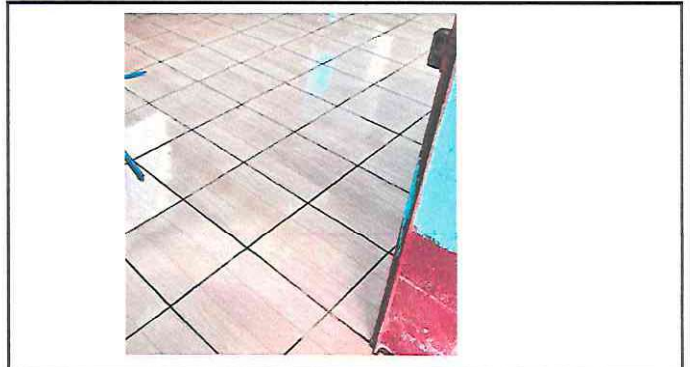
Foto 8: Sustitución de piso de torta de concreto por piso ceramico Aula 3
