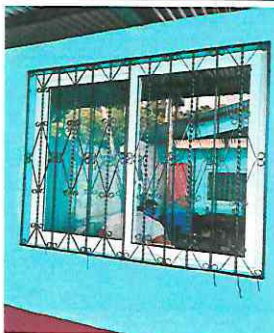
Foto 5: Instalación de ventana de PVC Aula 3
