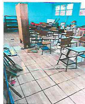
Foto 6: Sustitución de piso de granito por piso cerámico Aula 1
