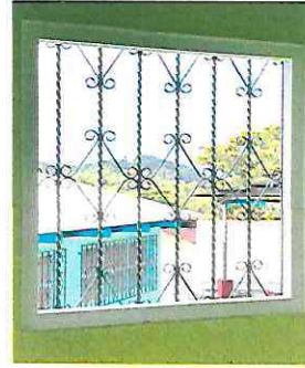
Foto 2: Mantenimiento a balcones de metal Aula 3
