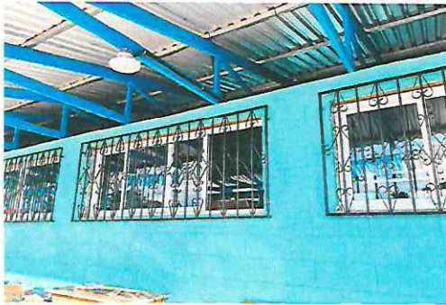
Foto 3: Instalación de ventana de PVC Aula 1
