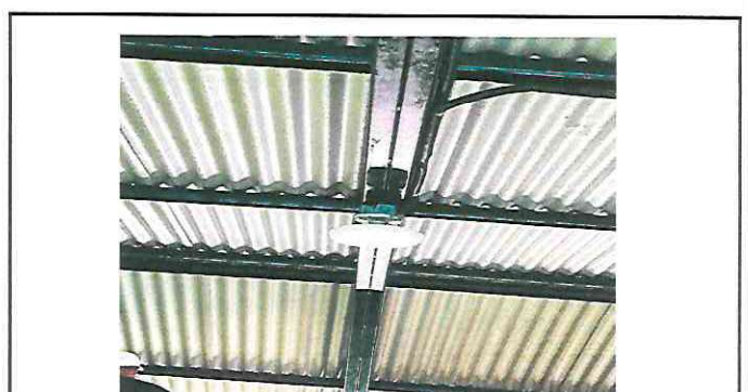
Foto 12: Mantenimiento a estructura de soporte de metal
