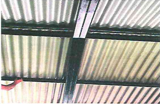
Foto 1: Mantenimiento a estructura de soporte de metal Aula 3
