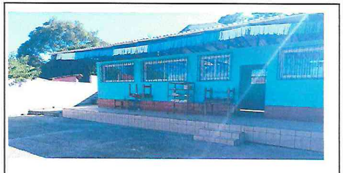
Foto 10: Sustitución de piso de granito por piso ceramico corredor
