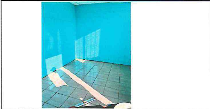
Foto 7: Sustitución de piso de granito por piso ceramico Aula 2
