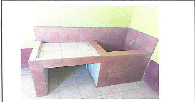
Foto 16: Reparación de pila de cemento de un lavadero
