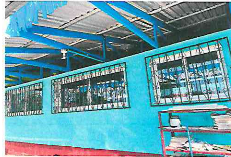
Foto 4: Instalación de ventana de PVC Aula 2
