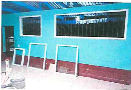
Foto 5: Instalación de ventana de PVC Aula 3
