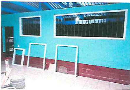
Foto 3: Instalación de ventana de PVC Aula 1
