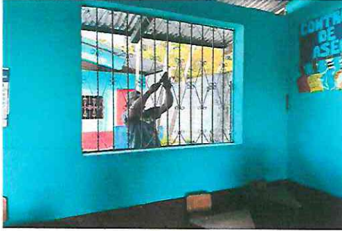
Foto 13: Matenimiento a balcones de metal
