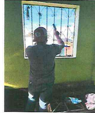
Foto 2: Mantenimiento a balcones de metal Aula 3
