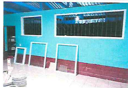
Foto 4: Instalación de ventana de PVC Aula 2
