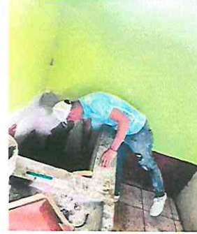
Foto 16: Reparación de pila de cemento de un lavadero
