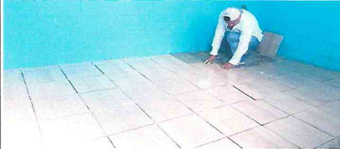
Foto 7: Sustitución de piso de granito por piso ceramico Aula 2
