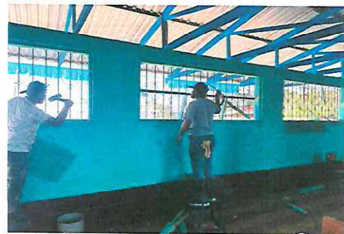
Foto 12: Mantenimiento a estructura de soporte de metal
