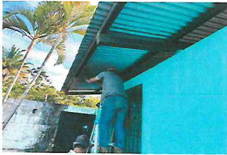
Foto 1: Mantenimiento a estructura de soporte de metal Aula 3
