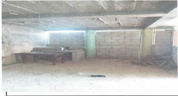
Foto 2: Instalación de piso cerámico en la cocina e instalación de azulejos en el polletón y repello, cernido de paredes.
