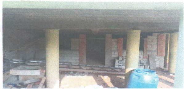
Foto 4: Instalación de piso de torta de concreto y piso cerámico en el comedor.
