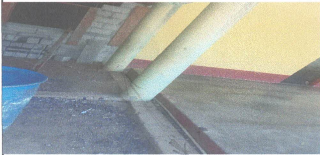
Foto 7: Continuidad de paredes de block, repello y cernido de paredes
