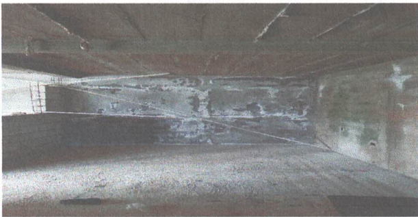
Foto 3: repello y cernido de paredes en la cocina.
