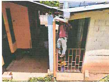
Foto 4: Sustitución de canal de pvc
