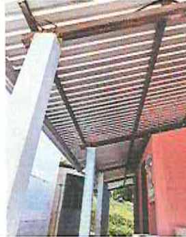
Foto 2: Sustitución de estructura de soporte de madera, por metal
