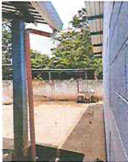
Foto 5: Reparación de bajada de agua pluvial, tubo PVC 3
