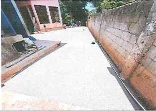
Foto 7: Reparación de planchas de concreto de patio
