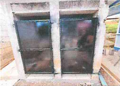
Foto 3: Sustitución de puerta en servicios sanitarios
