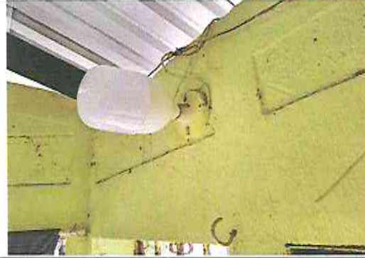
Foto 8: Sustitucion de lamparas LED
