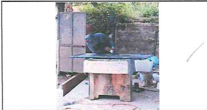
Foto 3: Sustitución de puerta en servicios sanitarios
