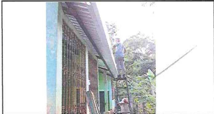
Foto 4: Sustitución de canal de pvc
