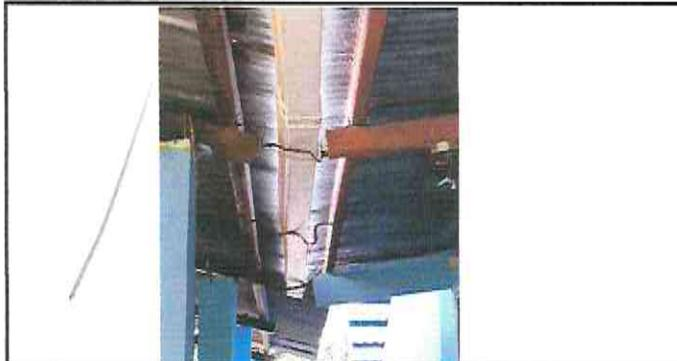
Foto 4: Sustrucción de canal de pvc
