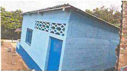
Foto1: Sustitución de lámina, por lamina troquelada aluzinc calibre 26
