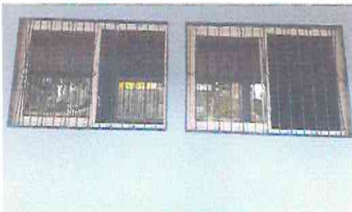
Foto 5: Mantenimiento a balcones de metal y sustitución de ventas de madera por pvc
