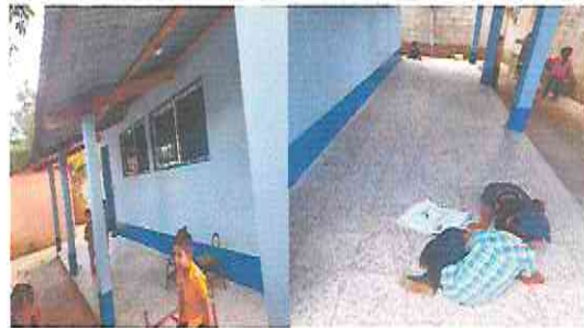
Foto 4: Pintura en muros exteriores e interiores
