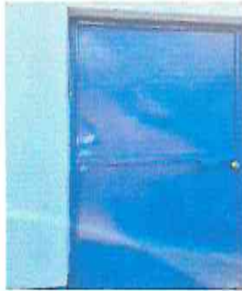
Foto 3: Sustitución de puerta
