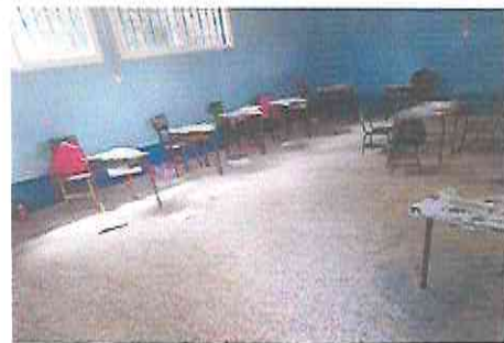
Foto 6: Sustitución de piso de granito
