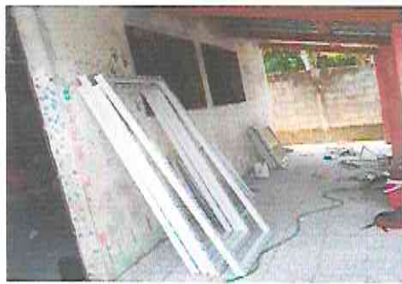
Foto 5: Mantenimiento a balcones de metal y sistitucion de ventas de madera por pvc
