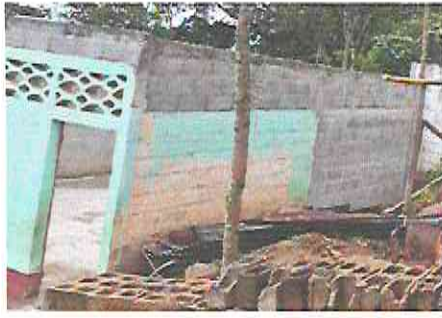
Foto1: Sustitución de lámina, por lamina troquelada aluzinc calibre 26
