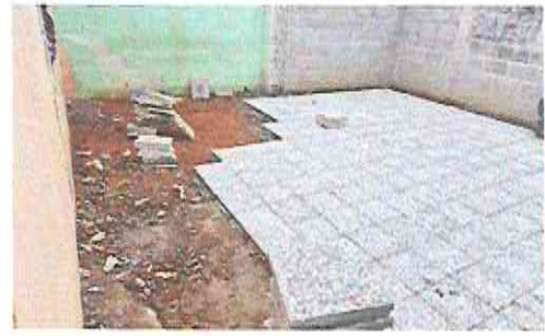
Foto 6: Sutitución de piso de granito
