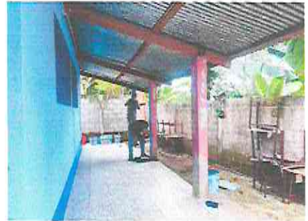
Foto 4: Pintura en muros exteriores e interiores
