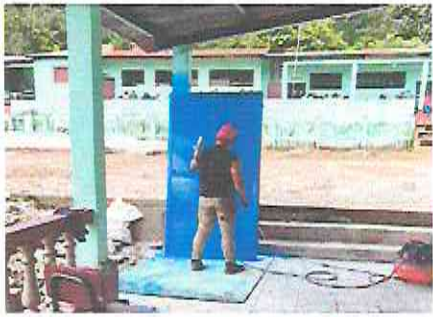
Foto 3: Sustitución de puerta
