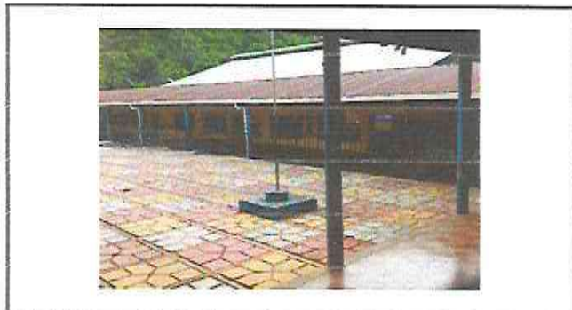
Foto 3: Patio: Instalación de canales pvc e instalación de barandal parte de abajo.
