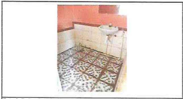
Foto 6: Baño: Instalación de piso ceramico.
