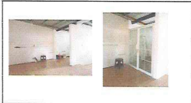
Foto1: Dirección. Levantado sobre muro, sustitución de lamina, sustitución soporte de madera por metal.
