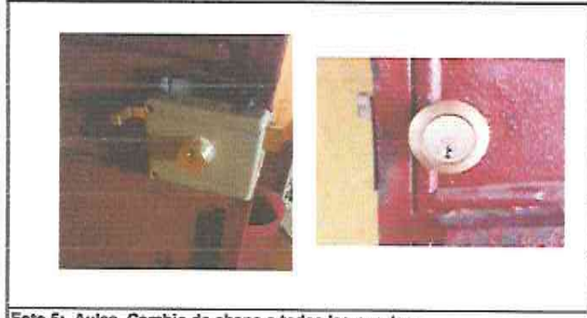
Foto 5: Aulas. Cambio de chapa a todas las puertas.
