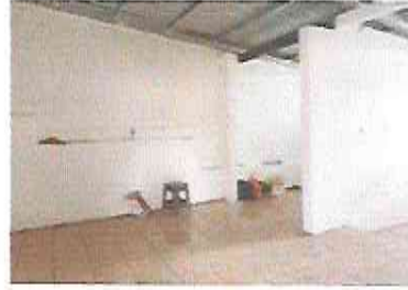
Foto 8: Alisado en muros e instalación de piso cerámico.
