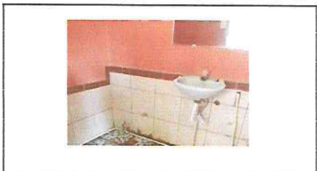
Foto 4: Baños: sustitución de accesorios de lavamanos.
