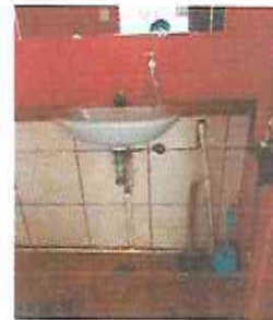
Foto 4: Baños: sustitución de accesorios de lavamanos.
