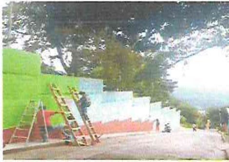
Foto 7: Pintura en muro exterior frente.
