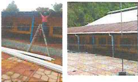
Foto 3: Patio: instalación de canales pvc e instalación de barandal parte de abajo.
