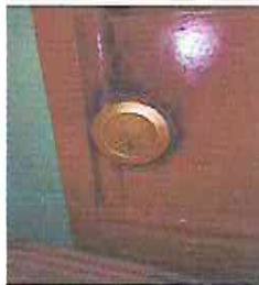
Foto 5: Aulas. Cambio de chapa a todas las puertas.
