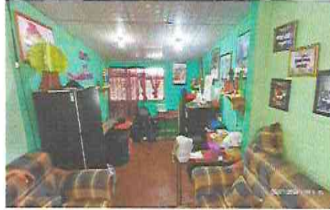
Foto 8: Alisado en muros e instalación de piso cerámico.
