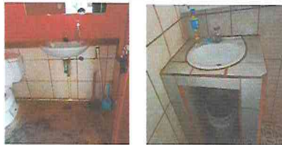
Foto 4: Baños: sustitución de accesorios de lavamanos.
