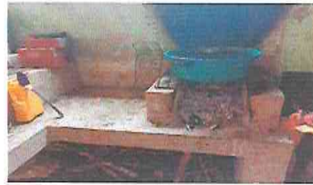
Foto 2: Cocina: Instalación de plancha.
