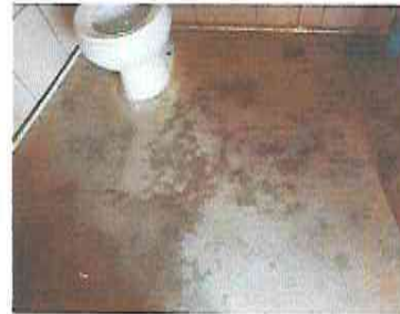
Foto 6: Instalación de piso ceramico.
