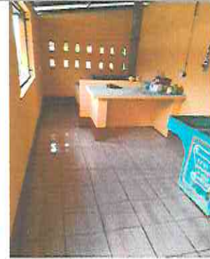
Foto 8: Reparación de altura de cocina en block
