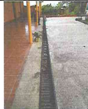
Foto 18: Mantenimiento a reposaderas
