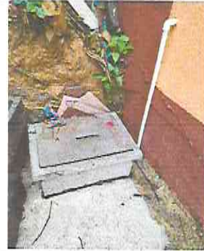
Foto 20: Sustrucción de tubería línea principal
