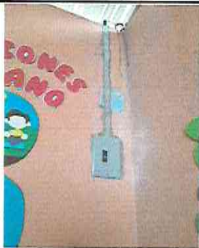
Foto 23: Sustrucción de tablero de flipones
