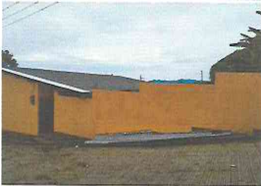
Foto 21: Reparación de muro perimetral de block.
