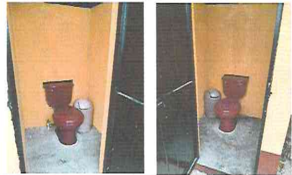
Foto 12: Sustitución de inodoros
