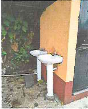
Foto 13: Reparación de banquetas de concreto en lavamanos
