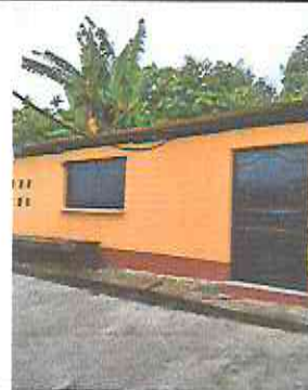
Foto 6: Pintura en muros exteriores e interiores
