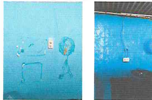
Foto 24: Sustrucción interruptores dobles
