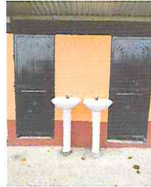
Foto 14: Reparación de banquetas de concreto en baños
