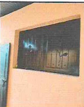
Foto 3: Mantenimiento a estructura de metal de ventana
