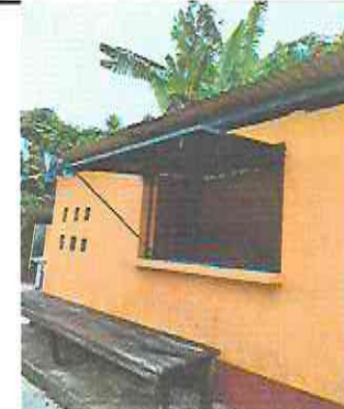
Foto 10: Instalación de ventana de metal en cocina
