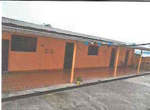
Foto 4: Pintura en muros exteriores e interiores
