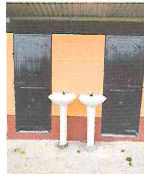
Foto 16: Pintura en muros exteriores e interiores
