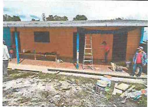
Foto 4: Pintura en muros exteriores e interiores
