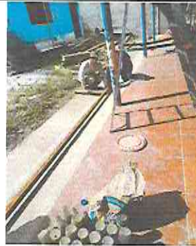
Foto 18: Mantenimiento a reposaderas
