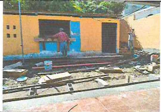
Foto 10: Instalación de ventana de metal en cocina
