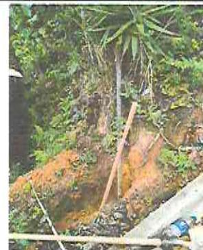
Foto 20: Sustitución de tubería línea principal
