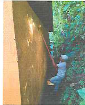
Foto 16: Pintura en muros exteriores e interiores
