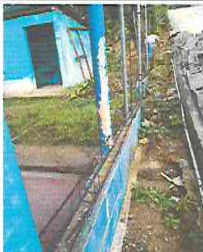
Foto 21: Reparación de muro perimetral de block.
