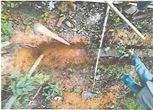
Foto 19: Sustitución de caja de registro
