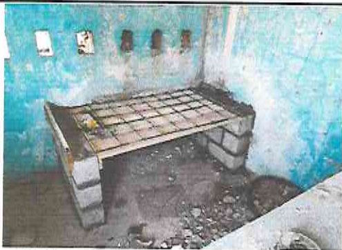
Foto 5: Sustitución de estufa rural (completa) incluye chimenea y plancha de metal
