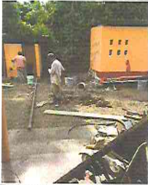
Foto 13: Reparación de banquetas de concreto en lavamanos
