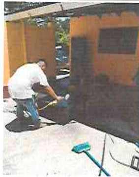
Foto 3: Mantenimiento a estructura de metal de ventana
