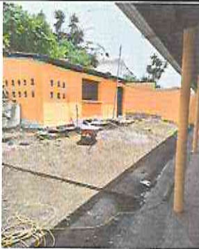
Foto 17: Reparación de planchas de concreto de patio
