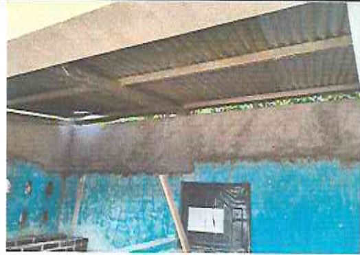
Foto 8: Reparación de altura de cocina en block
