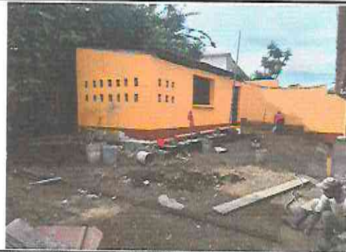
Foto 6: Pintura en muros exteriores e interiores
