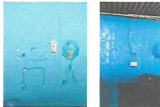
Foto 24: Sustitución interruptores dobles
