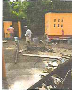
Reparación de banquetas de concreto en baños
