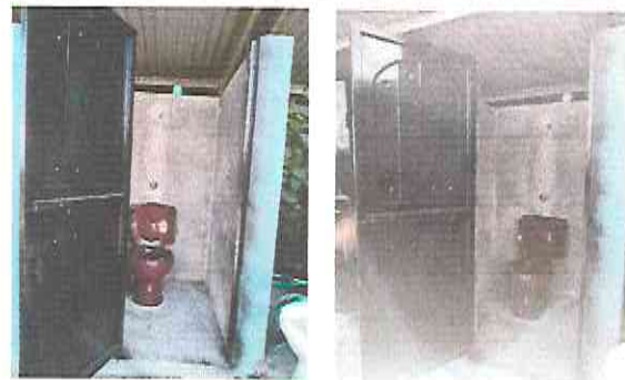
Foto 12: Sustitución de inodoros
