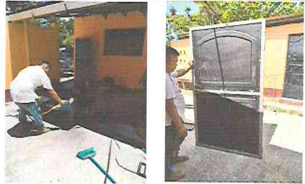
Foto 2: Mantenimiento a estructura de puerta (lijado, aplicación de pintura)
