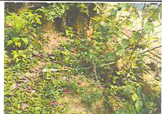
Foto 20: Sustitución de tubería línea principal
