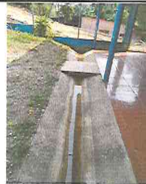
Foto 18: Mantenimiento a reposaderas
