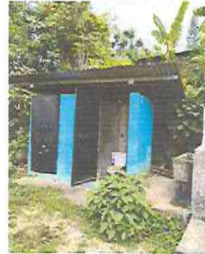
Foto 14: Reparación de banquetas de concreto en baños
