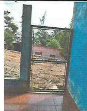
Foto 22: Sustitución de portón de maya por portón de lámina con chapa
