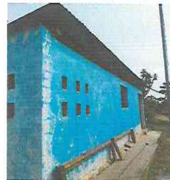
Foto 10: instalación de ventana de metal en cocina
