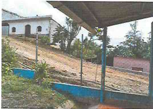
Foto 21: Reparación de muro perimetral de block.
