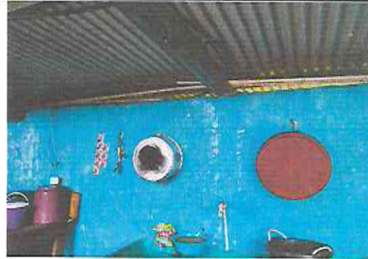
Foto 8: Reparación de altura de cocina en block
