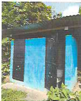
Foto 11: Mantenimiento a estructura (lijado, aplicación de pintura) a puertas servicios sanitarios
