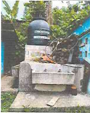
Foto 13: Reparación de banquetas de concreto en lavamanos
