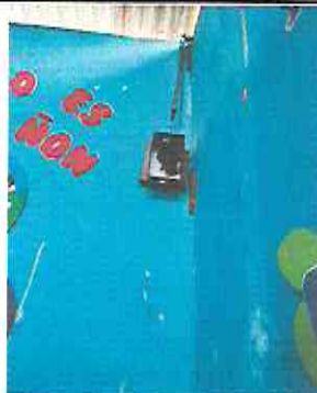
Foto 23: Sustitución de tablero de flipones
