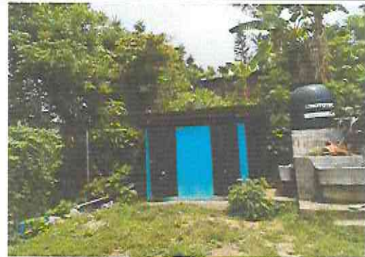
Foto 16: Pintura en muros exteriores e interiores
