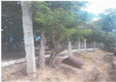
Foto 9: Reforzamiento de columnas de circulación con muros de block y soleras armadas para evitar caídas.
