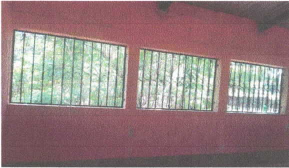
Foto 7: Mantenimiento de balcones de metal.
