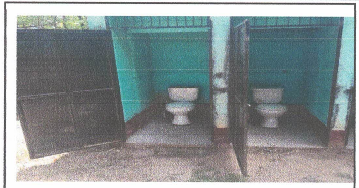
Foto 2: Sustitución de inodoros.
