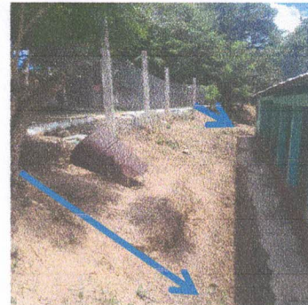
Foto 10: Fabricación de cunetas de concreto para encausar aguas pluviales.
