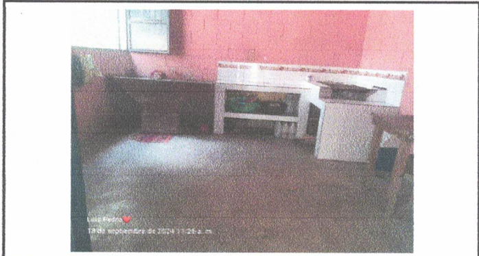
Foto13: Sustitución de piso ceramico a cocina
