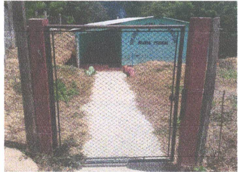
Foto 8: Fabricación de techo de ingreso y mantenimiento de portón metálico.
