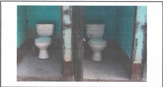
Foto 5: Sustitución de azulejo en servicios sanitarios.
