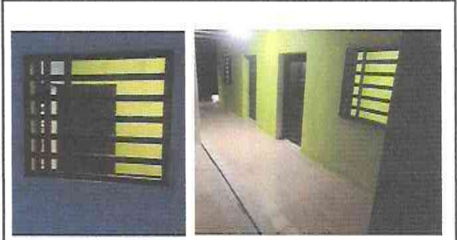
Foto 2: Módulo 1 Sustitución de balcones de metal
