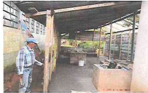
foto 4: Módulo de cocina: Reparación de piso de cemento líquido
