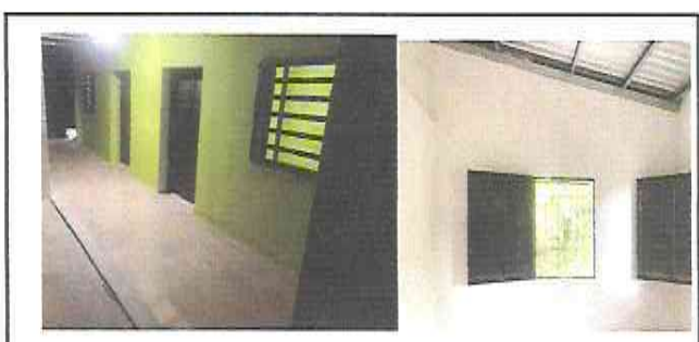
Foto 4: Módulo 1: Repello y cernido de pared
