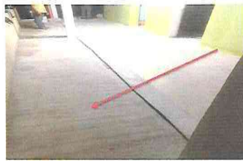
Foto 8: Módulo 1: Reparación de banqueta de concreto
