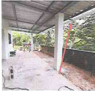
Foto7: Módulo 1: Sustitución de canal de metal y Sustitución de bajada de agua pluvial , tubo PVC 3"
