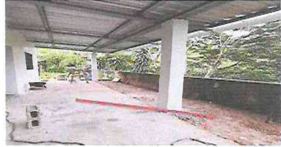
Foto 8: Módulo 1: Reparación de banqueta de concreto
