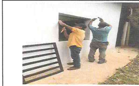
Foto 2: Módulo 1 Sustitución de balcones de metal
