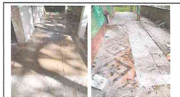
Foto 6: Módulo 1: sustitucion de piso cerámico
