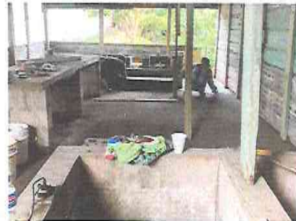
foto 4: Módulo de cocina: Reparación de piso de cemento líquido
