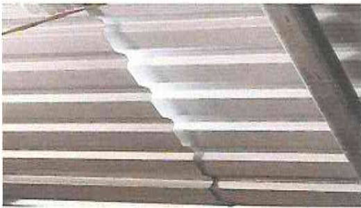
Foto1: Módulo 1: Mantenimiento de estructura de soporte de metal y Sustitución de cubierta metálica con lámina troquelada calibre 26
