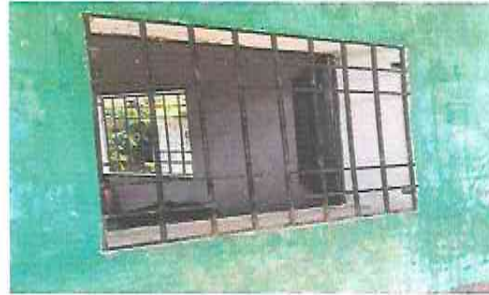
Foto 2: Módulo 1 Sustitución de balcones de metal
