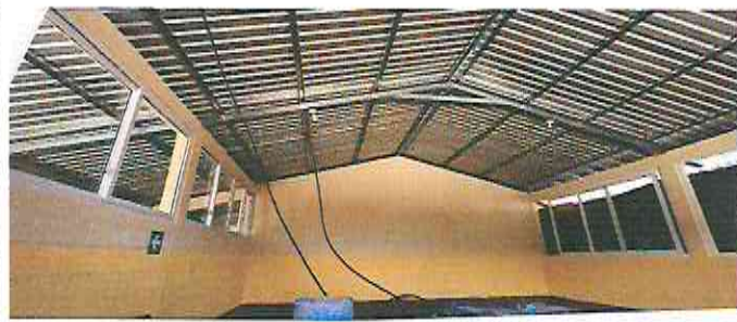
FOTO 3: SUSTITUCION DE VENTANAS DE METAL POR PVC MAS VIDRIO
