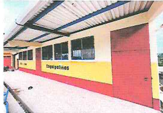
FOTO 4: PINTURA EN MUROS EXISTENTES
