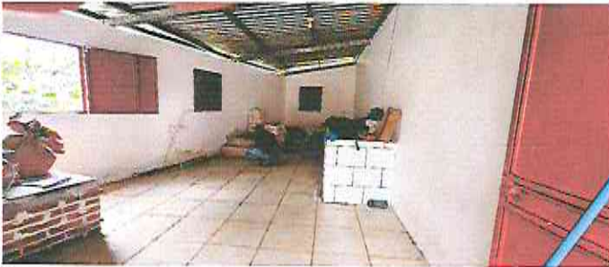
FOTO 5: REPELLO EN MURO
