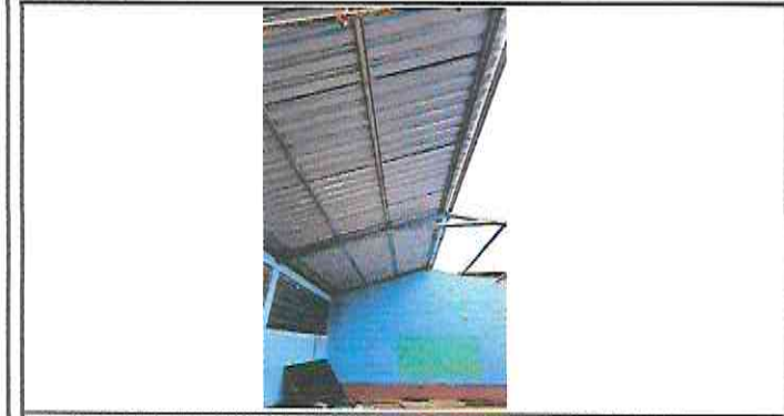
FOTO 1: SUSTITUCION DE LAMINA, POR LAMINA TROQUELADA ALUZINC CALIBRE 26
