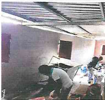
FOTO 5: REPELLO EN MURO
