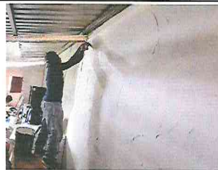
FOTO 6: ALISADO EN MURO
