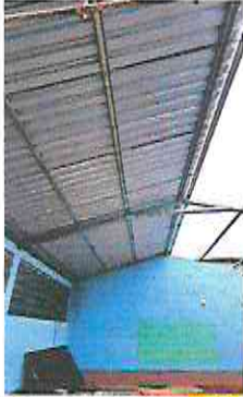
FOTO 1: SUSTITUCION DE LAMINA, POR LAMINA TROQUELADA ALUZINC CALIBRE 26
