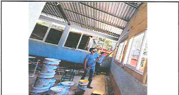
FOTO 4: PINTURA EN MUROS EXISTENTES
