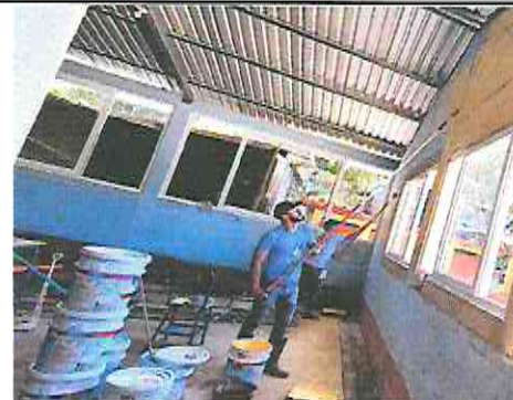
FOTO 4: PINTURA EN MUROS EXISTENTES
