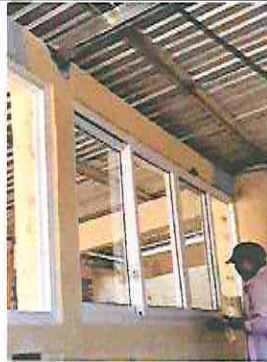
FOTO 3: SUSTITUCION DE VENTANAS DE METAL POR PVC MAS VIDRIO
