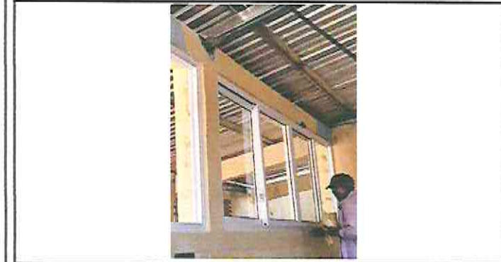
FOTO 3: SUSTITUCION DE VENTANAS DE METAL POR PVC MAS VIDRIO
