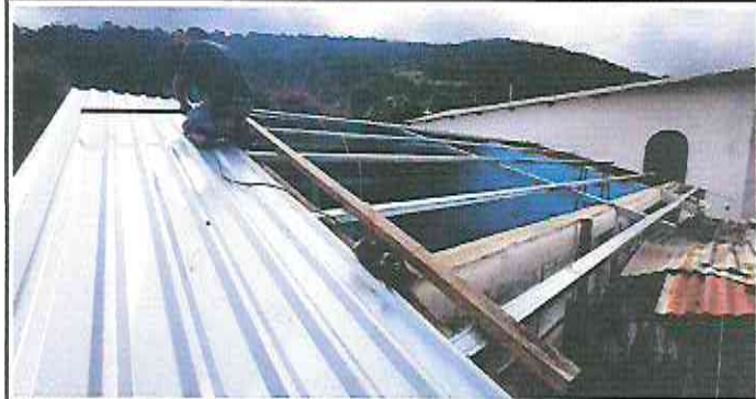
FOTO 2: SUSTITUCION DE ESTRUCTURA DE SOPORTE DE METAL, POR METAL
