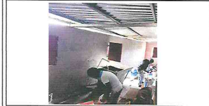
FOTO 5: REPELLO EN MURO
