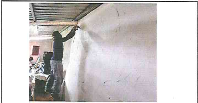
FOTO 6: ALISADO EN MURO
