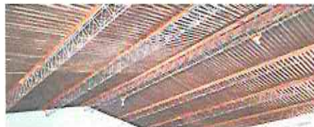
FOTO 2: SUSTITUCION DE ESTRUCTURA DE SOPORTE DE METAL, POR METAL
