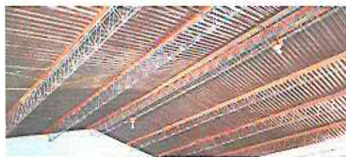
FOTO 1: SUSTITUCION DE LAMINA, POR LAMINA TROQUELADA ALUZINC CALIBRE 26
