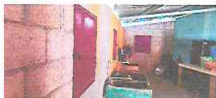
FOTO 5: REPELLO EN MURO
