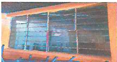
FOTO 3: SUSTITUCION DE VENTANAS DE METAL POR PVC MAS VIDRIO
