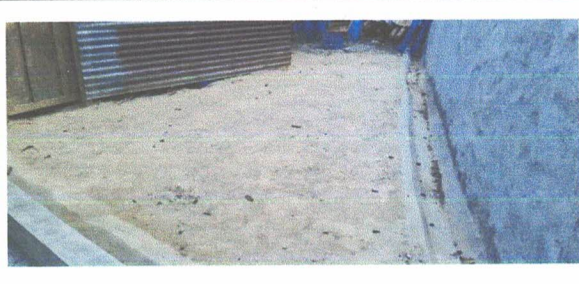
Foto 2: MEJORAMIENTO DE PISO DE CONCRETO EN PATIOS
