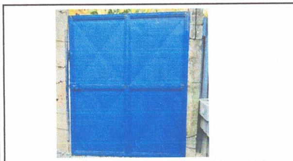
Foto 3: SUSTITUCION DE PORTON, ENTRADA PRINCIPAL 2.5 X 2.5 M
