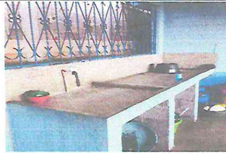
Foto 4: INSTALACIÓN DE AZULEJO
