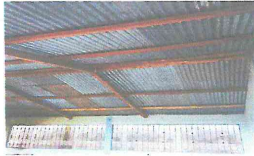
Foto 2: ESTRUCTURA DE TECHO
