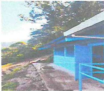
Foto 5: INSTALACIÓN DE CANALES PVC
