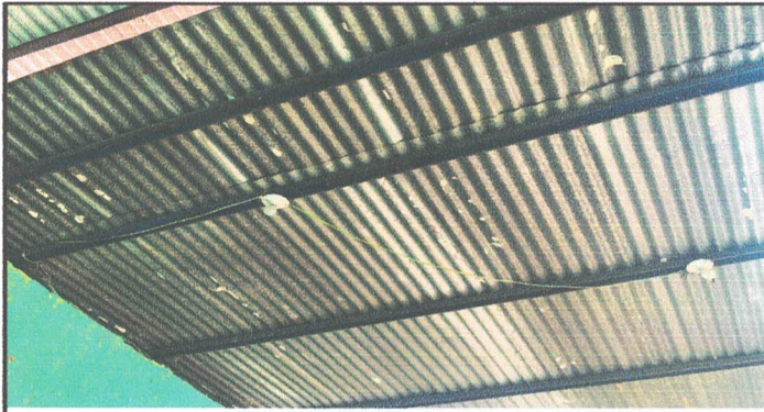
Foto 15: Instalación de unidades luz
