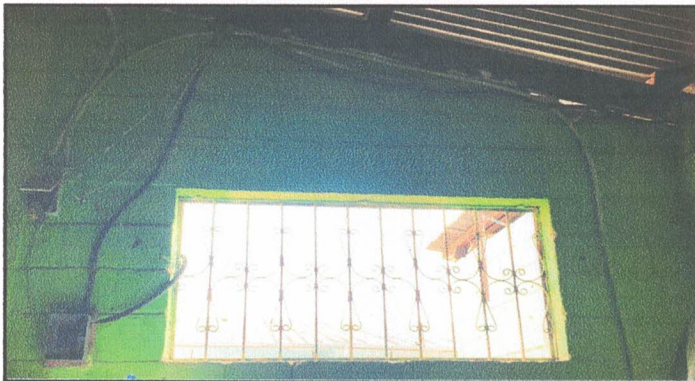
Foto 9: Sustitución de cableado electrico
