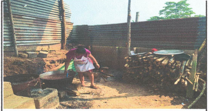
Foto 14: Instalación de lámina troquelada aluzinc
