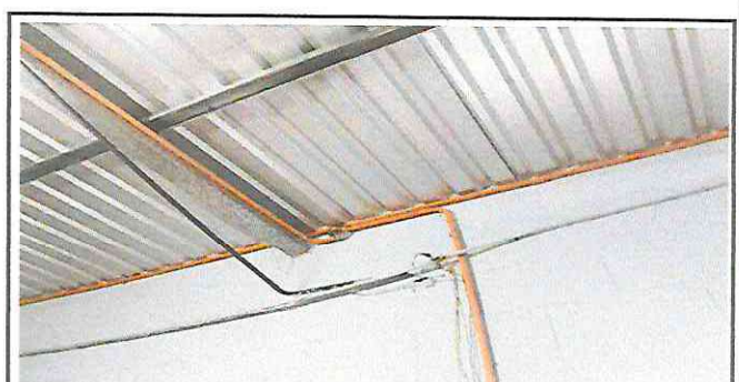
Foto 6: Reparación de cable eléctrico, cable sólido #10 línea principal y ramales cable #12 y cambiar tomacorrientes y apagadores.
