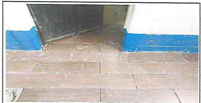
Foto 4: Sustitución de piso torta de cemento por piso cerámico
