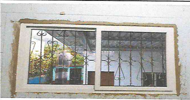
Foto 3: Sustitución de ventanas de celosía por venatan de PVC
