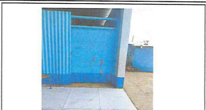
Foto 2: Sustitución de puerta de madera por puerta de metal
