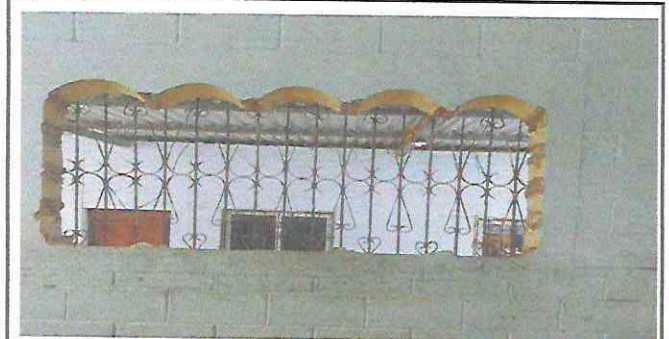
Foto 3: Sustitución de ventanas de celosía por venatan de PVC
