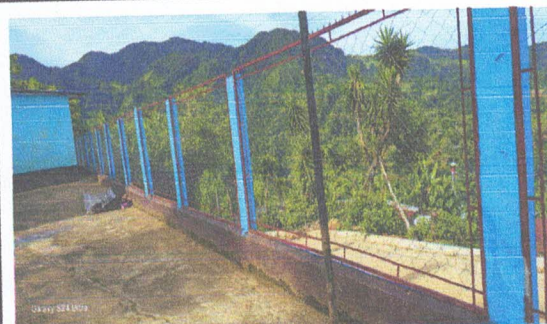
FOTO 6: MUROS PERIMETRALES (SUBIR 3 HILADAS DE BLOCK A LA PARTE DE ENFRETE DE LA ESCUELA)
