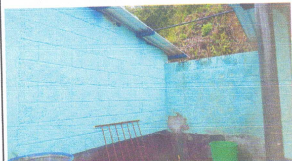
FOTO 5: PINTURA DE MUROS.
