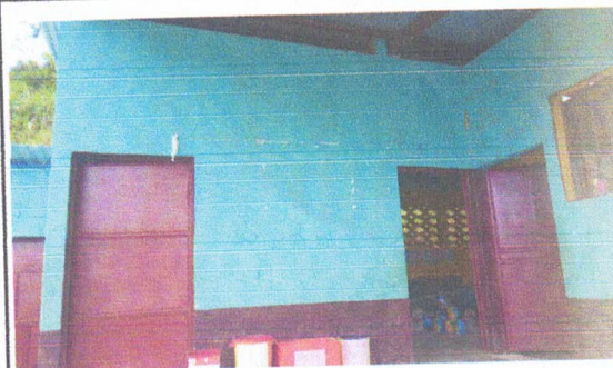
FOTO 4: MANTENIMIENTO DE PUERTAS.
