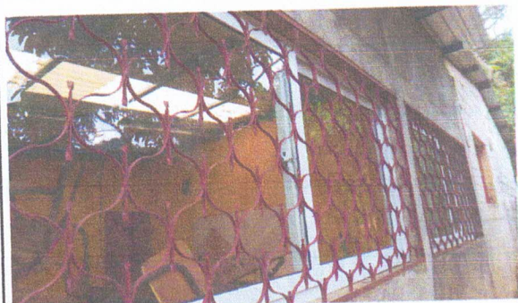
FOTO 3: MANTENIMIENTO DE BALCONES.
