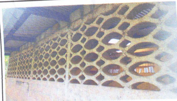
FOTO 2: RELLENADO DE ESPACIOS EN MURO Y CERNIDOS.
