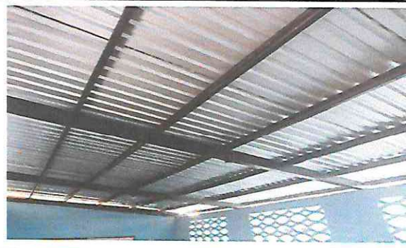
Foto 2: Mantenimiento de estructura de metal en aula #1
