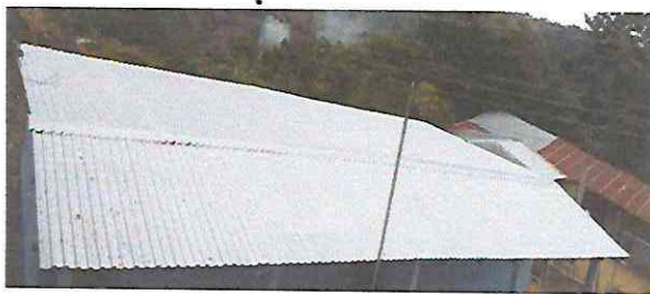
Foto 5: Sustitución de lamina por lamina troquelada calibre 26 en aula #2
