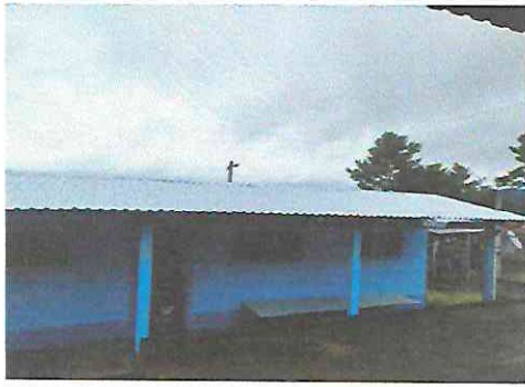
Foto1: Sustitución de lamina por lamina troquelada calibre 26 en Aula #1
