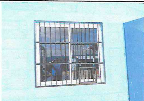
Foto 3: Fabricación e instalación de balcon de metal en cocina (Con balcon de buena calidad)
