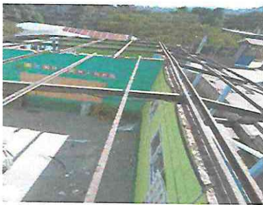
Foto 5: Sustitución de lamina por lamina troquelada calibre 26 en aula #2
