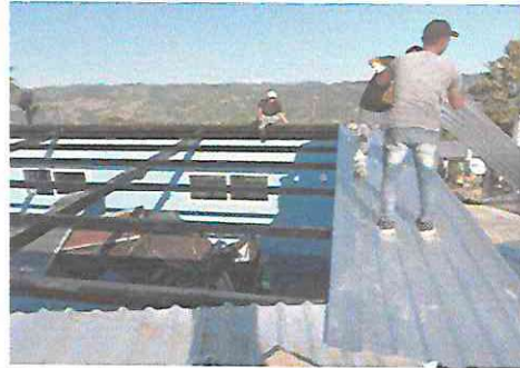
Foto 2: Mantenimiento de estructura de metal en aula #1
