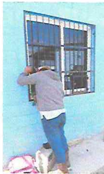
Foto 3: Fabricación e instalación de balcon de metal en cocina (Con balcon de buena calidad)
